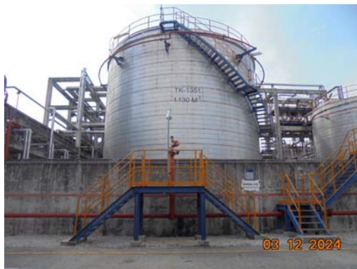
รูปที่ 3.2-56 ถังคอนกรีตล้อมรอบถังเก็บกัก
