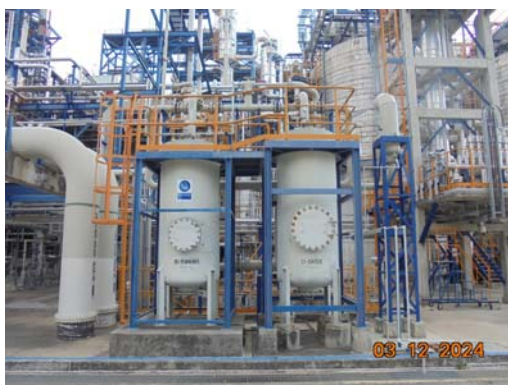
รูปที่ 3.2-4 ปล่องระบบดูดซับไอระเหย สารอินทรีย์ด้วยถ่านกัมมันต์จากระบวนการผลิต (D-1905A และ D-1905B)
