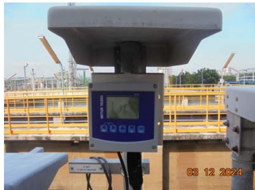
รูปที่ 3.2-19 ระบบตรวจวัดค่า pH แบบอัตโนมัติ
