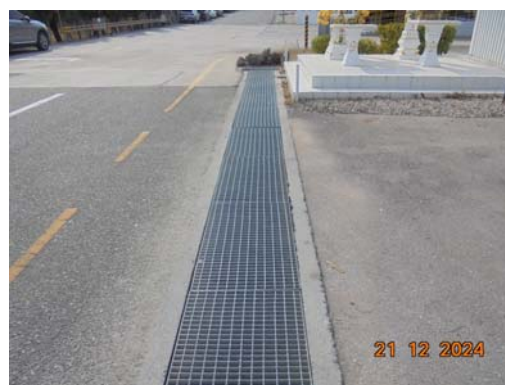
รูปที่ 3.1-7 รางระบายน้ำฝนบริเวณพื้นที่ก่อสร้าง
