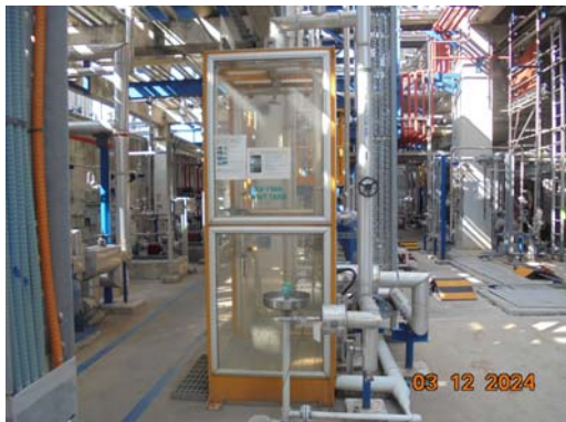
รูปที่ 3.2-50 อ่างล้างตาและร่างกายฉุกเฉิน
