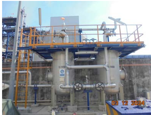
รูปที่ 3.2-6 ปล่องระบบดูดซับไอระเหยสารอินทรีย์ด้วยถ่านกัมมันต์ จากถัง TK-1922 TK-1923 (D-1906)
