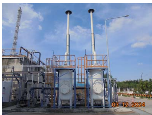
รูปที่ 3.2-5 ปล่องระบบดูดซับไอระเหย สารอินทรีย์ด้วยถ่านกัมมันต์จากระบบบำบัดน้ำเสีย (D-9201 และ D-9202)
